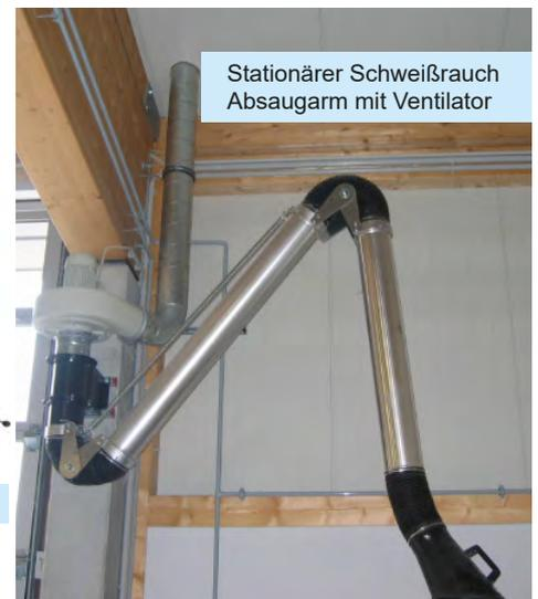
Stationärer Schweißrauch Absaugarm mit Ventilator
