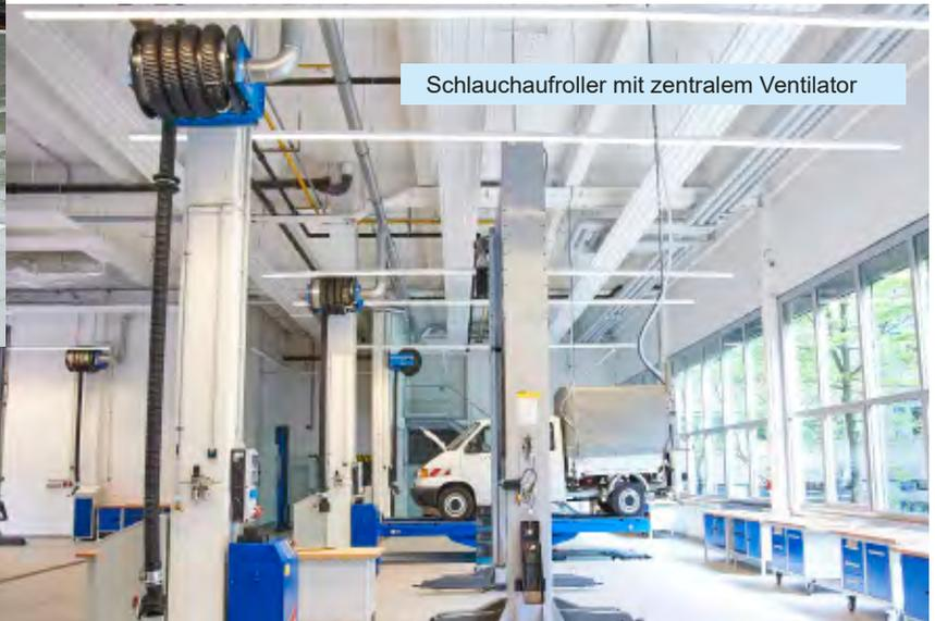
Schlauchaufroller mit zentralem Ventilator
