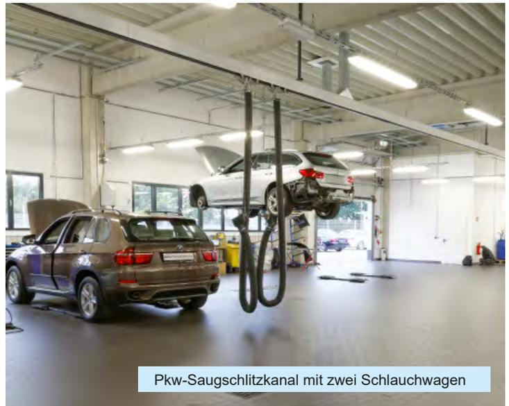
Pkw-Saugschlitzkanal mit zwei Schlauchwagen
