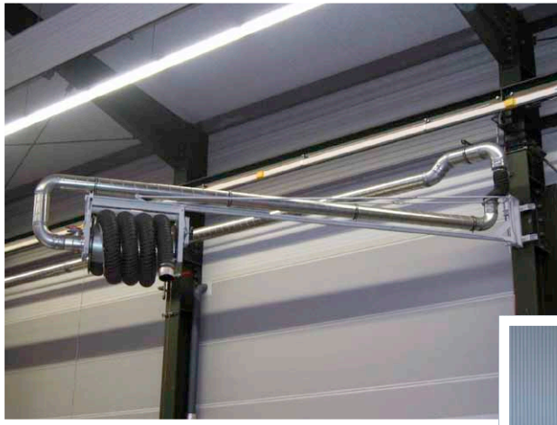
Elektrischer Aufroller am 6 m langen Schwenkausleger
