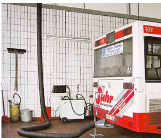
Oben: Saugschlitzkanal mit Schlauchwagen und leistungsstarkem Ventilator. Links: Verwendung in einer Buswerkstatt
