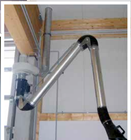
Links: Ventilator mit Konsole an Gebäudeaußenwand
