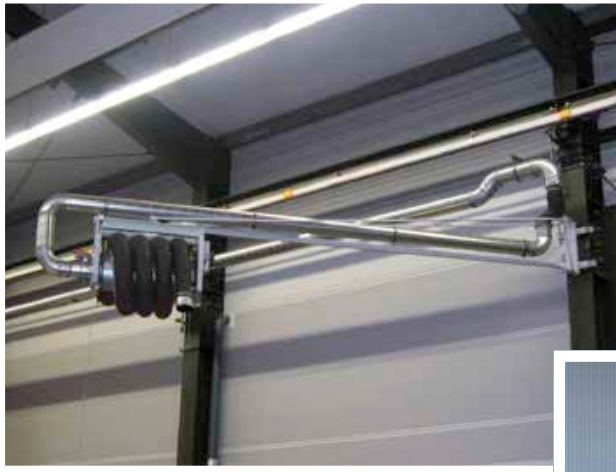
Elektrischer Aufroller am 6 m langen Schwenkausleger
