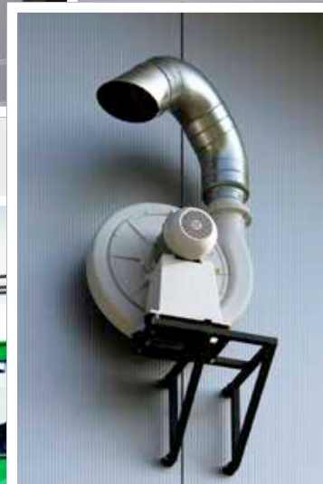
Links: Ventilator mit Konsole an Gebäudeaußenwand
